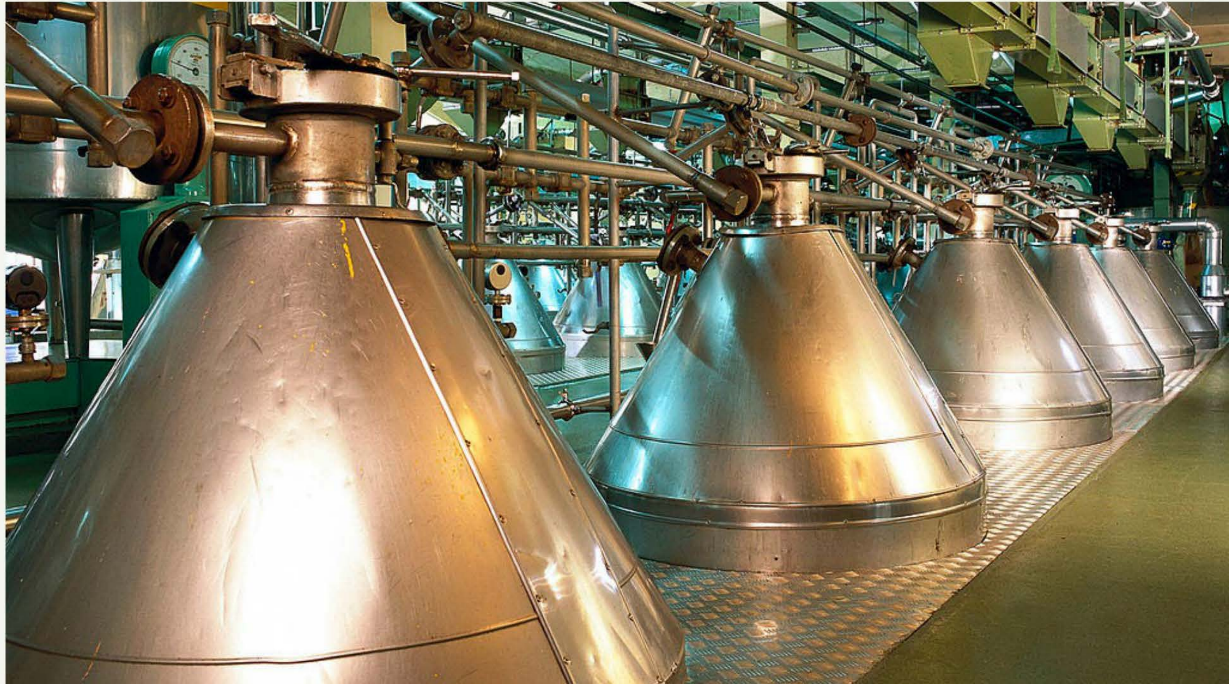
Großtechnische Extraktionsanlage für die Lebensmittelindustrie
