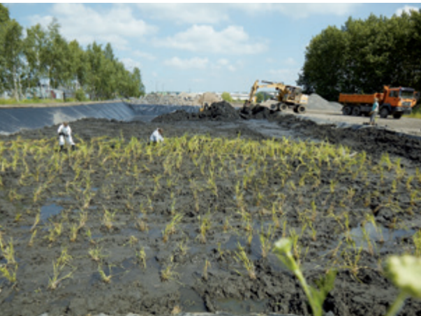
Fig. 12: Behandlung schwermetallhaltiger Sedimente durch Phytoremediation
