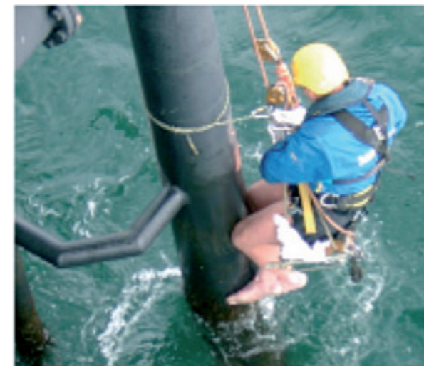
Abbildung 4.1.6.1 Wartungsarbeiten an einem Offshore-Bauwerk.[2]
