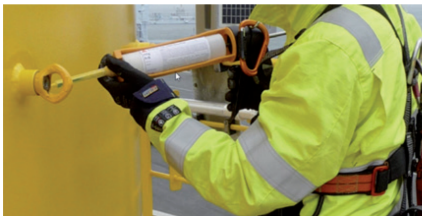
Abbildung 4.1.4.1 Kartuschensystem als umweltfreundliches Reparaturbeschichtungssystem
