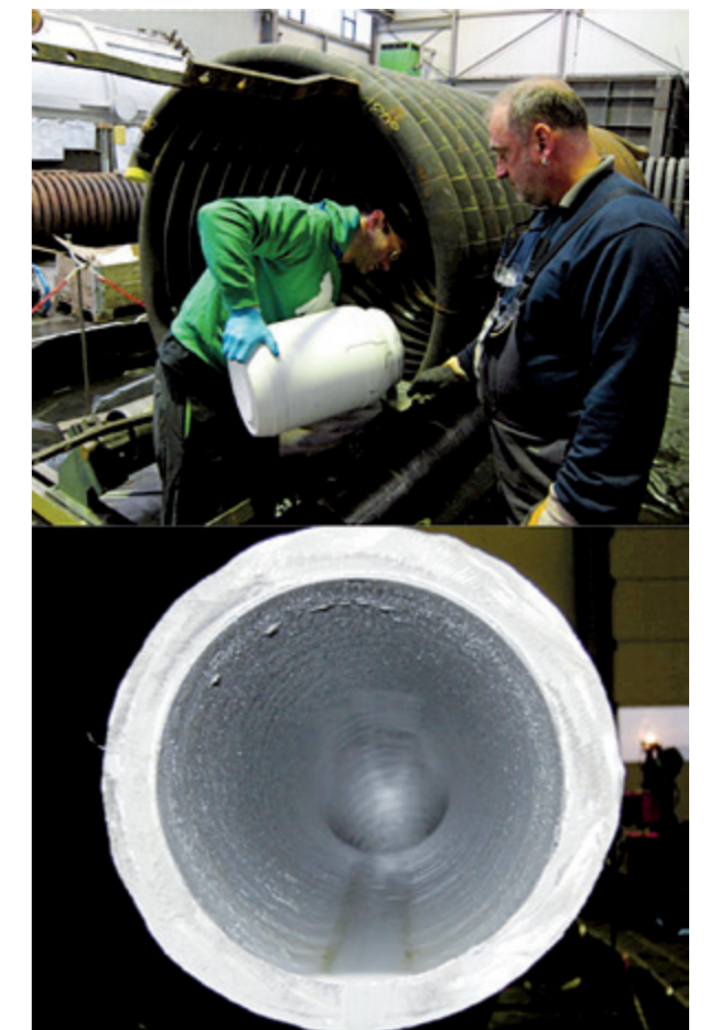
Abbildung 4.1.9.2 Aufbringung des Slurrys auf den Abhitzekessel; Coating direkt nach dem Aufbringen
